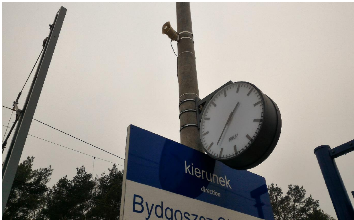
Fot. 5. Głośnik SIP zainstalowany na peronie 1 stacji Bydgoszcz Leśna
